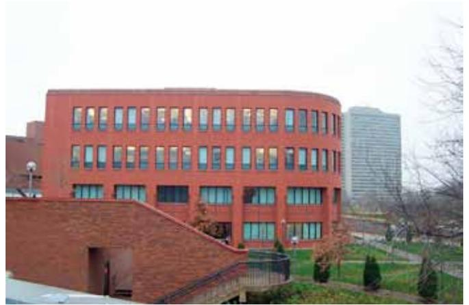
アンダーセン図書館(写真上)は地上 5 階建てで 10 万平方フィートの貸出図書館で、基盤下 50 フィートに 84,000 平方フィートの記録文書施設(表紙写真)を有する。この 2 つの施設は、エレベーターおよび階段で繋がれている。プレキャストコンクリートと鉄骨構造である。
